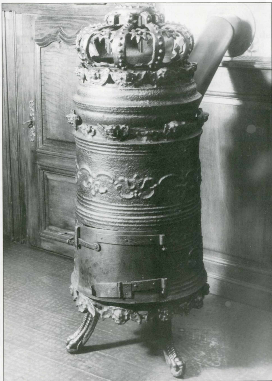
Les fonderies de fer du sud-est de la Belgique, réputées pour les « taques de cheminée », a produit également des poêles en fonte ; leur confection relevait cependant de la technique de fabrication de cloches. Poêle millésimé du XVIII e siècle.
